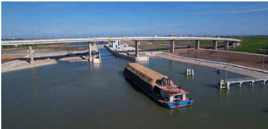
Toàn cảnh công trình kênh nối Đáy - Ninh Cơ
