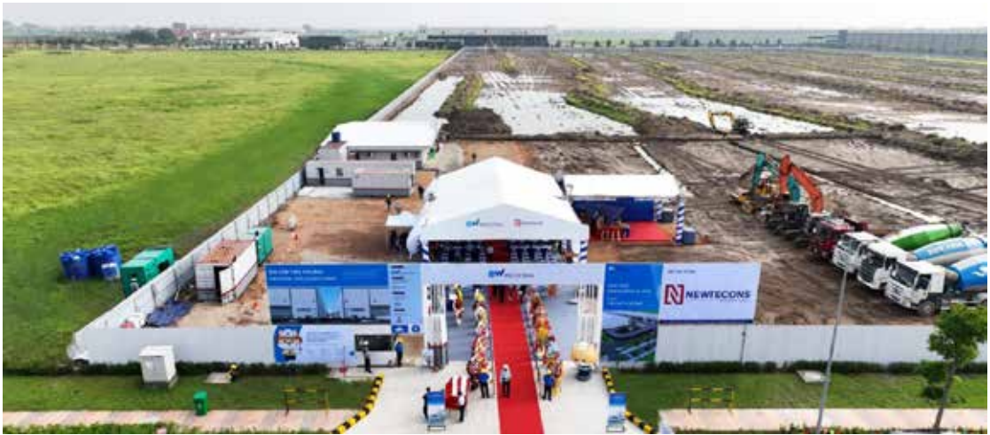
Lễ khởi công dự án nhà kho 2 tầng Nam Sơn Hạ Lĩnh tháng 6/2024
